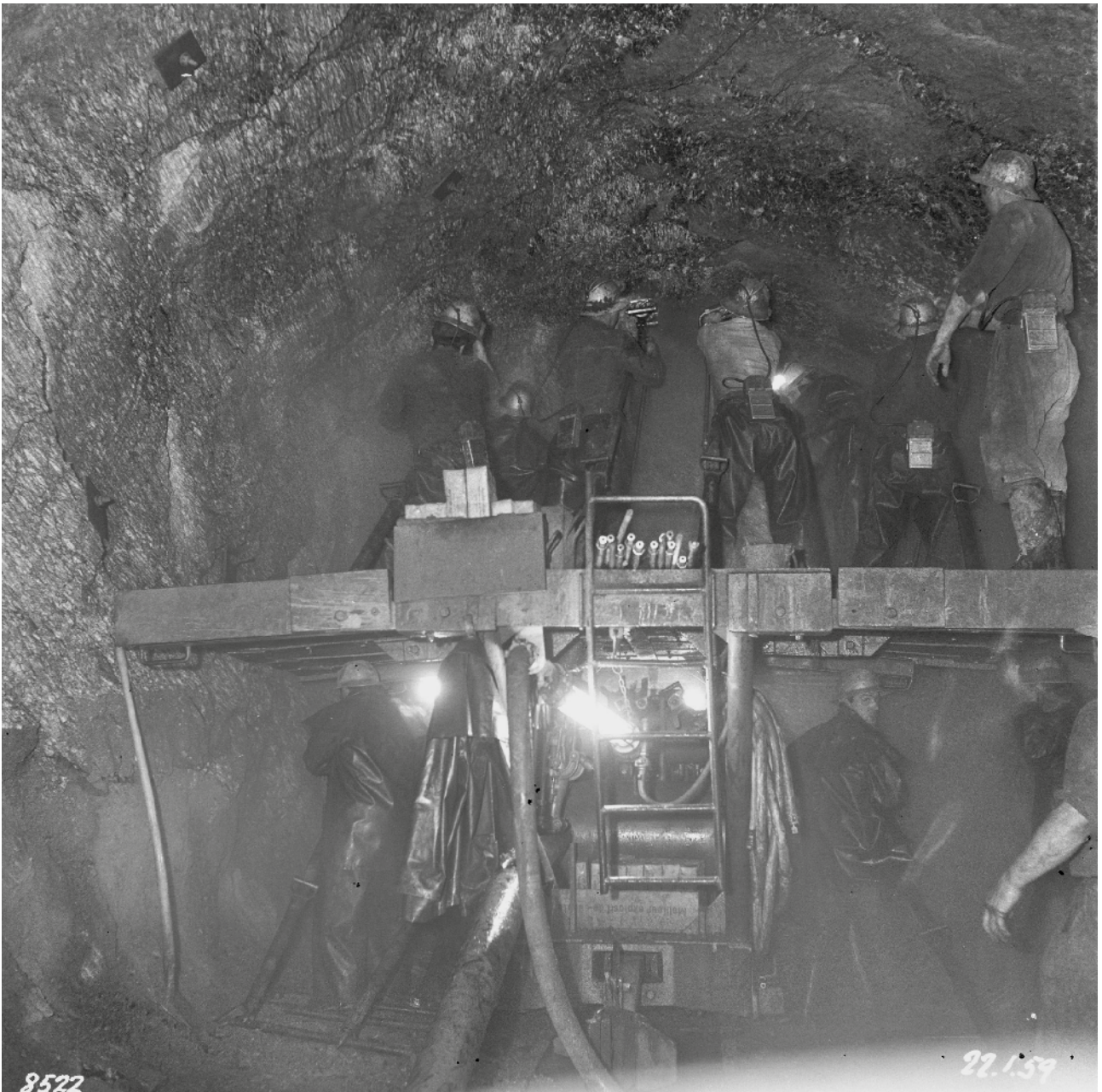
Sopra: Biasca, gennaio 1959 – Una squadra di minatori perfora la roccia della galleria.
