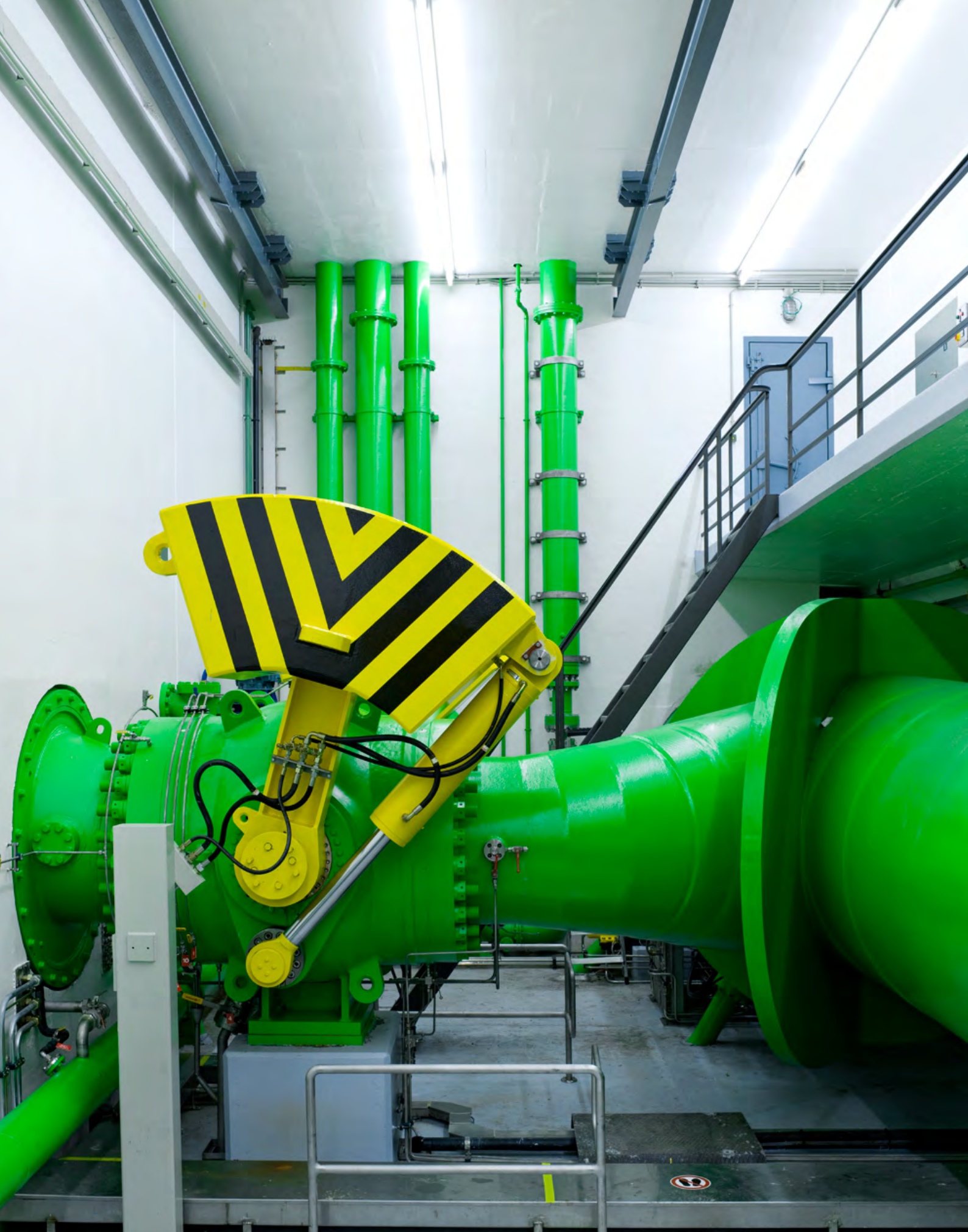
Auf Umschlag und auf dieser Seite: Kraftwerk Biasca, Kugelschieber
