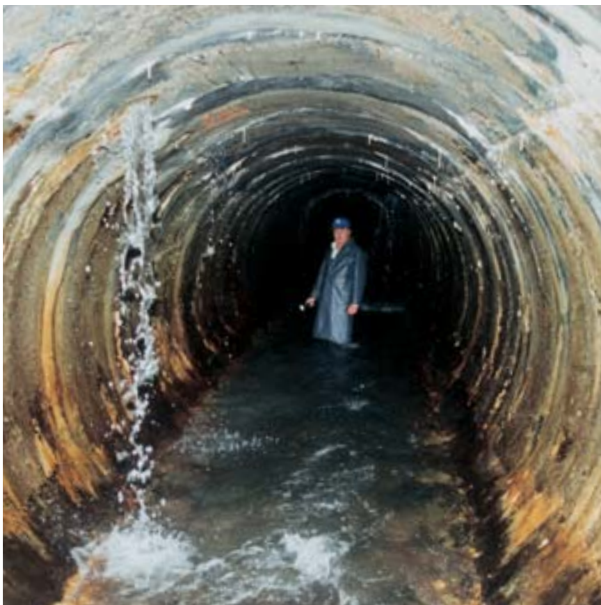
Pian Segno 1999. Ispezione della galleria.
